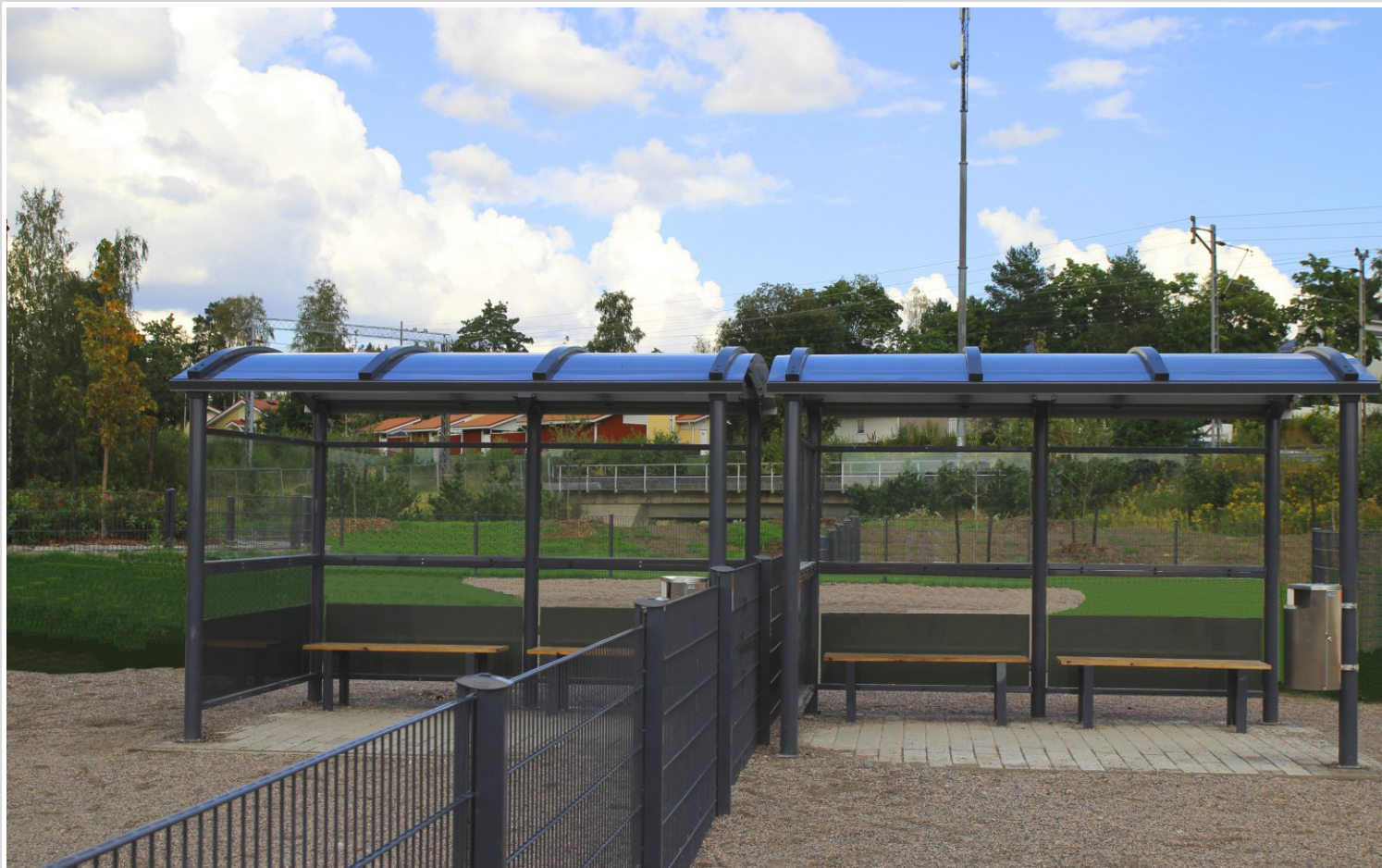
Koirapuiston katokset Järvenpäässä
